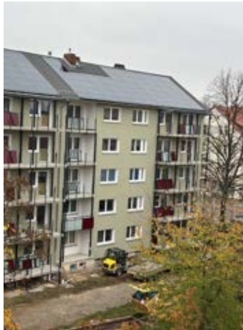
Hofansicht Balkonbau Friedl. Weg 13+15
