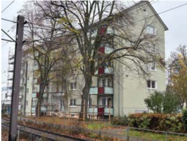
Balkonbau Wallensteinstr. 4-6 Südseite mit Vorstellbalkone + Sanierung Alt-Balkone
